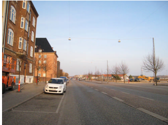
自転車道路(建物右から歩道、自転車道、 駐車スペース、車道)
