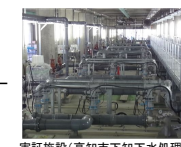
実証施設(高知市下知下水処理場)
