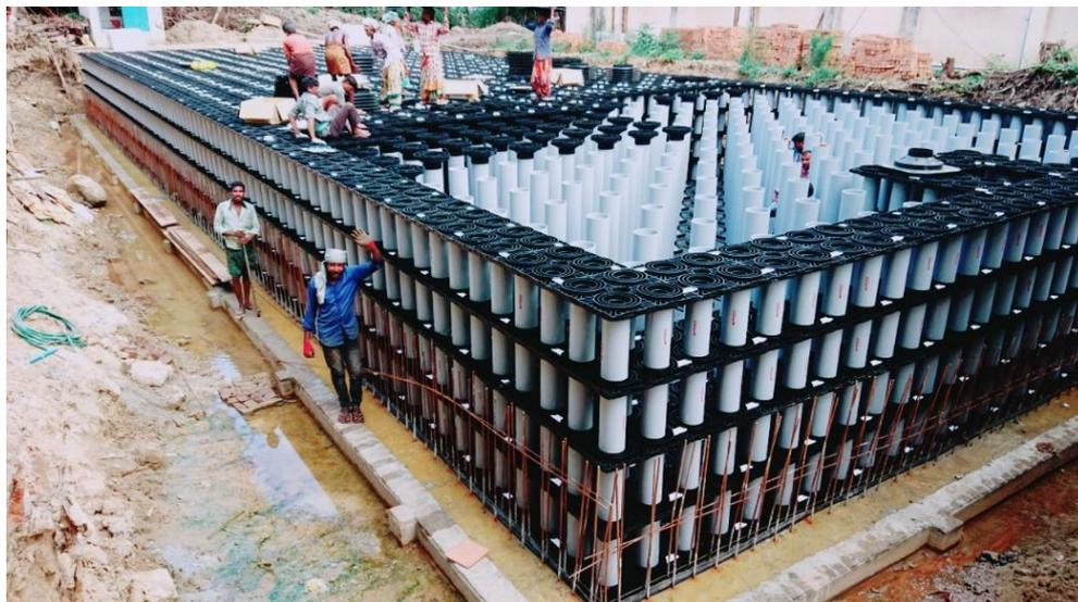
インドで施工した600 tの貯水槽の施工途中写真
